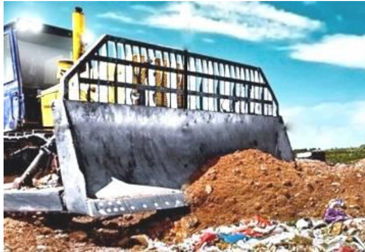
Слика бр. V-3: Формирање на покривен слој од земја со помош на булдозер
